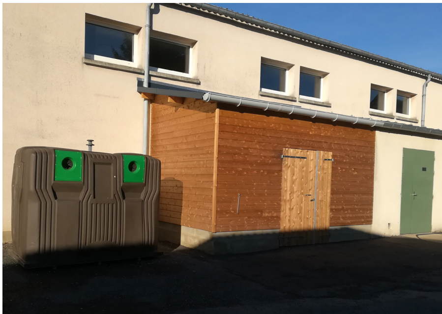
Toilettes et nouveau local poubelle
